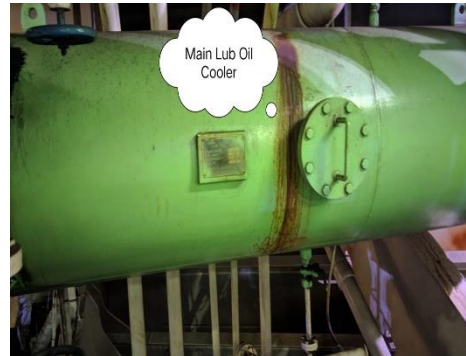
Gambar 1. Main L.O Cooler M/E
