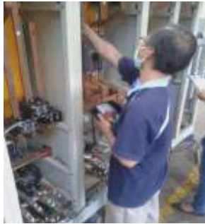
Gambar 6. Proses pengujian dan pengukuran tahanan isolasi
