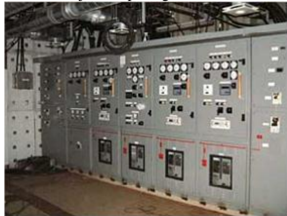
Gambar 4 Konstruksi Main Switch Board
